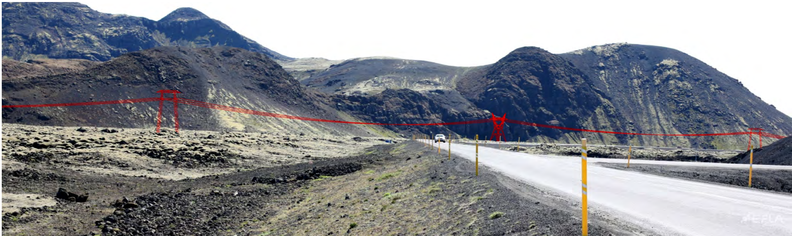
8. Þorlákshafnarlína 2. Horft úr myndapunkti 2 við Þrengslaveg til suðurs eftir veginum. Að lokinni framkvæmd. Líkan af mannvirkinu er sýnt í rauðum lit.
