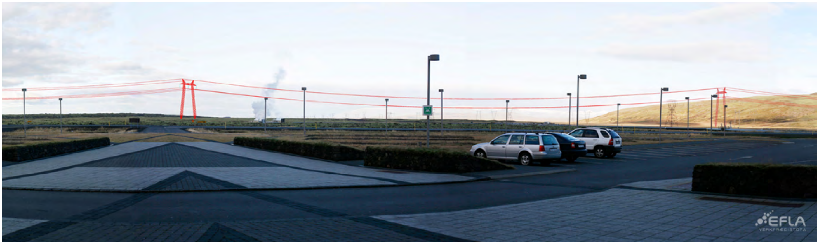
65. Þorlákshafnarlína 2. Horft frá bílastæði við Hellisheiðarvirkjun, úr myndapunkti 12. Að lokinni framkvæmd. Líkan af mannvirkinu er sýnt í rauðum lit.
