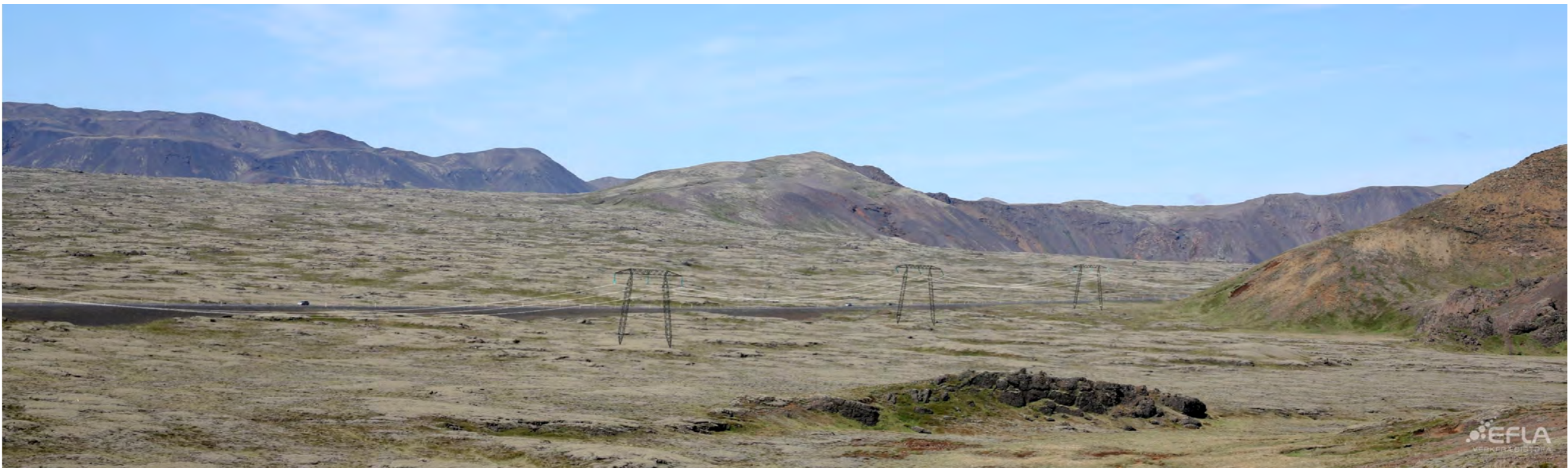
19. Þorlákshafnarlína 2, valkostur B. Horft frá Meitiltagli til norðvesturs í myndapunkti 3, Lambafellsháls í bakgrunni. Að lokinni framkvæmd.
