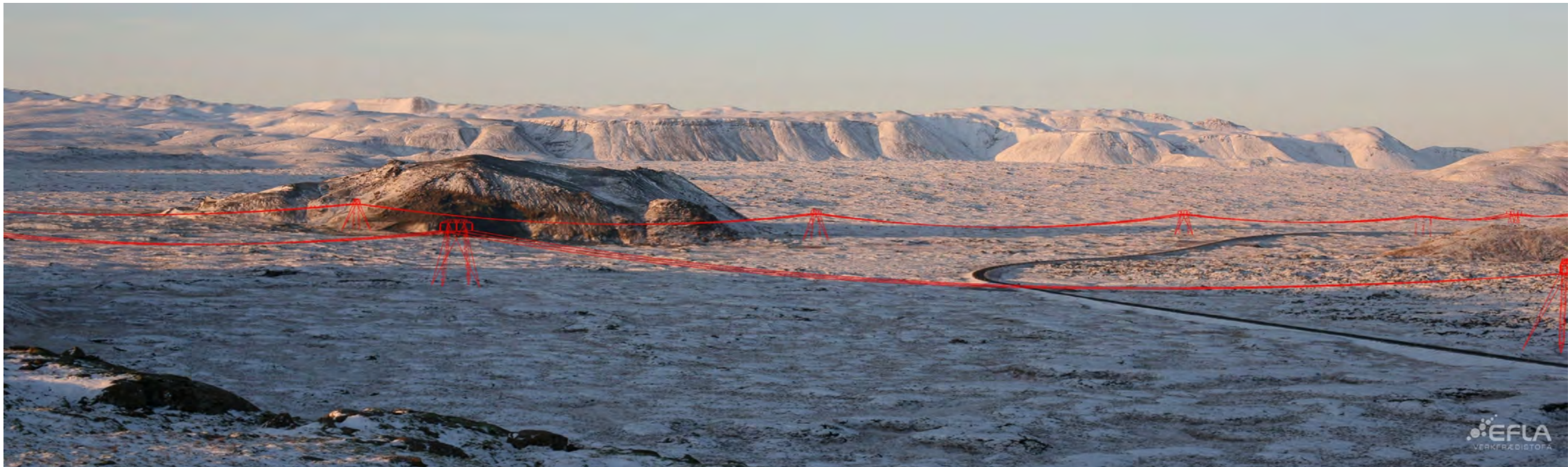
39. Þorlákshafnarlína 2, valkostur B og Þorlákshafnarlína 3, valkostur A. Horft frá myndapunkti á 4 Krossfjöllum til norðvesturs að Sandfelli. Þrengslavegur til hægri. Að lokinni framkvæmd. Líkan af mannvirkinu er sýnt í rauðum lit.
