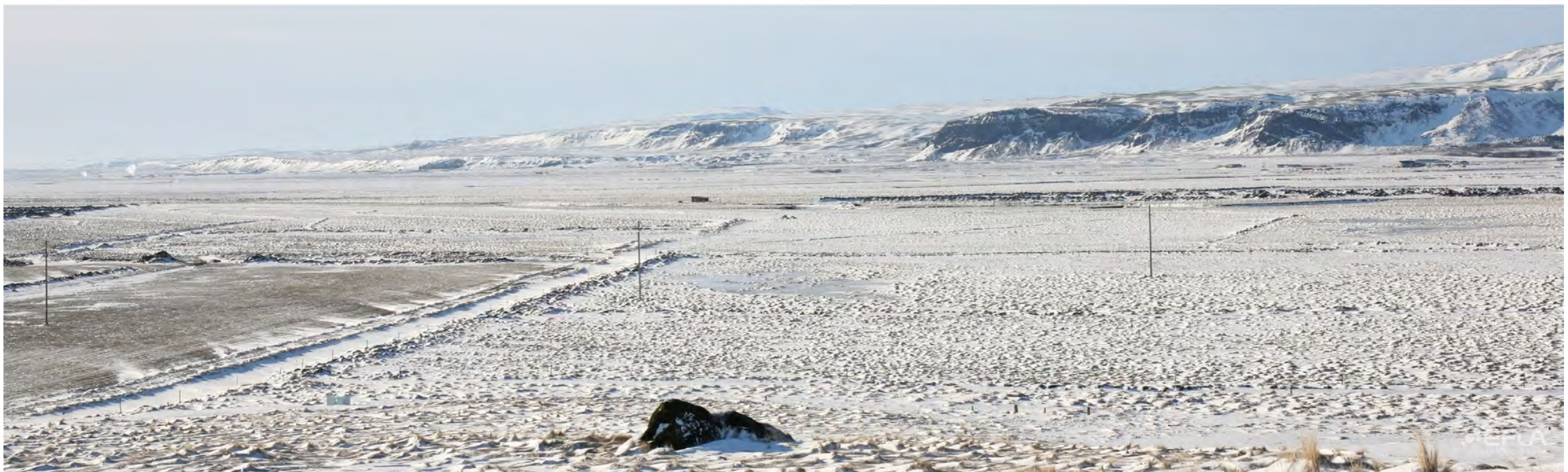
21. Þorlákshafnarlína 3, valkostur A. Horft frá Kotströnd, myndpunktur 7. Að lokinni framkvæmd.
