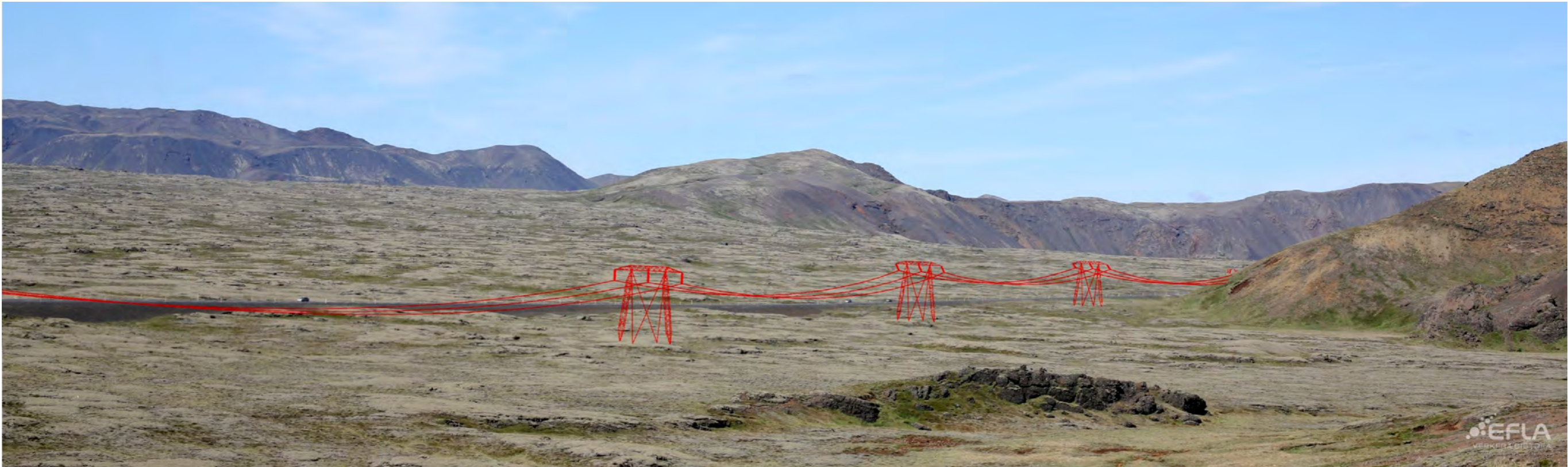
18. Þorlákshafnarlína 2, valkostur B. Horft frá Meitiltagli til norðvesturs í myndapunkti 3, Lambafellsháls í bakgrunni. Að lokinni framkvæmd. Líkan af mannvirkinu er sýnt í rauðum lit.
