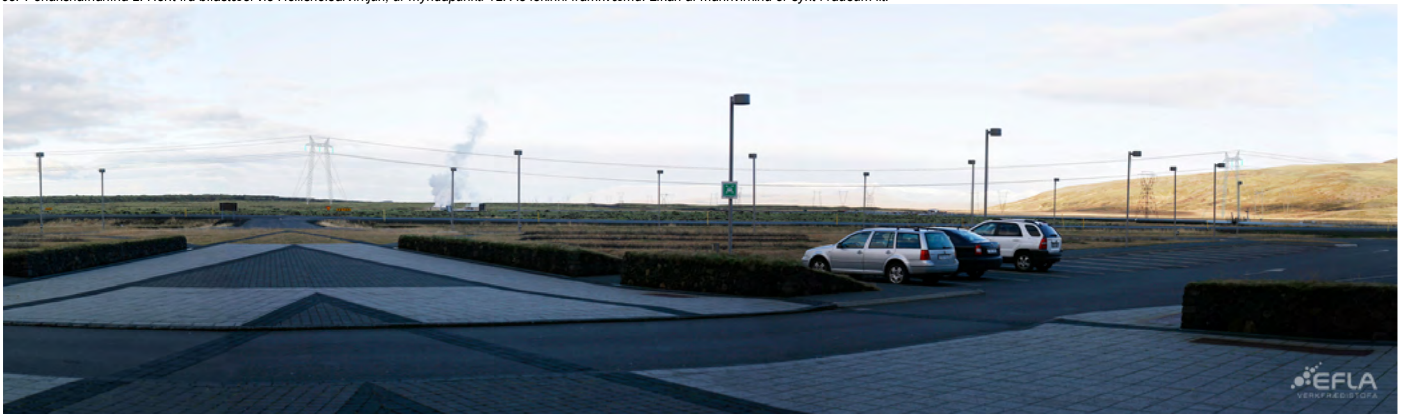
66. Þorlákshafnarlína 2. Horft frá bílastæði við Hellisheiðarvirkjun, úr myndapunkti 12. Að lokinni framkvæmd.
